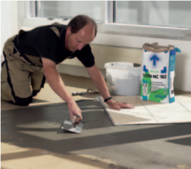
Przy pomocy UZIN NC 182 można szybko i bez wysiłku niwelować różnice wysokości podłoża.
